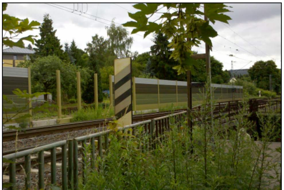
2,4 Millionen Euro teure "Schallschutz"-Wand - viel Geld für wenig Effekt
